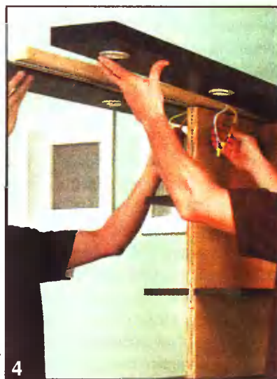
4 Установив и подключив светильники, крепят карниз.
