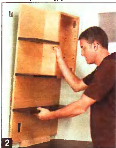
2 Панель настенного блока крепят к стене с помощью металлических крючьев-кронштейнов.
