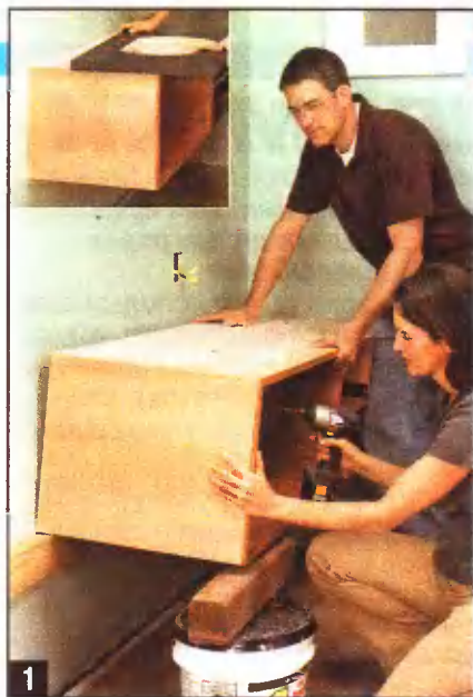
1 Просверлив отверстия в монтажной планке (см. рис.2, поз.Ф), корпус столика крепят шурупами к стене.
