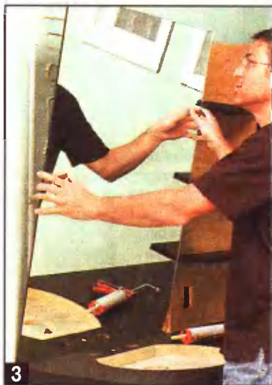
3 Зеркало приклеивают непосредственно к стене специальным клеем.
